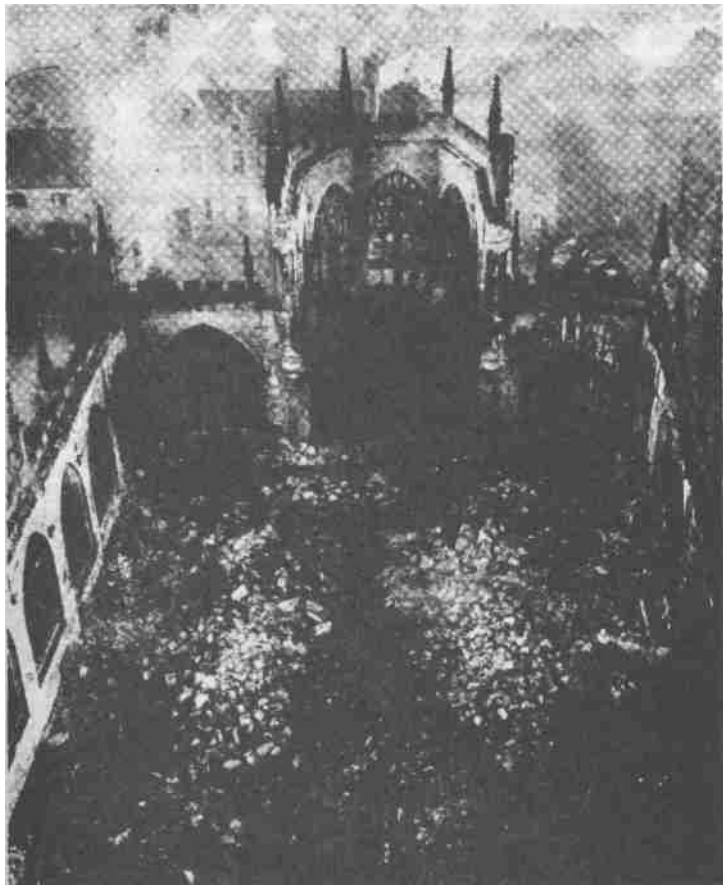
Die Mauern der Kathedrale von Coventry, nachdem die Kirche am 14. November 1940 durch Bomben zerstört wurde.
